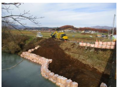
河川区域工事
